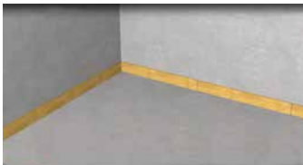
Randisolatie aanbrengen
