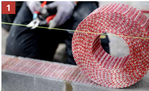
1 Plaats Murfor® Compact koud op de stenen
