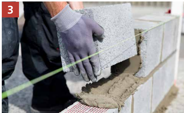
3 Plaats de volgende steenlaag
