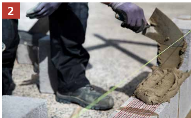
2 Breng daarna een laag mortel aan
